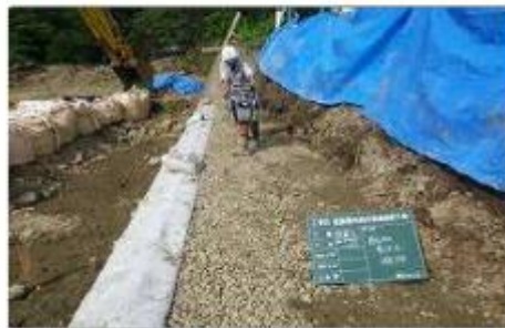
( 裏込砕石転圧状況 )
